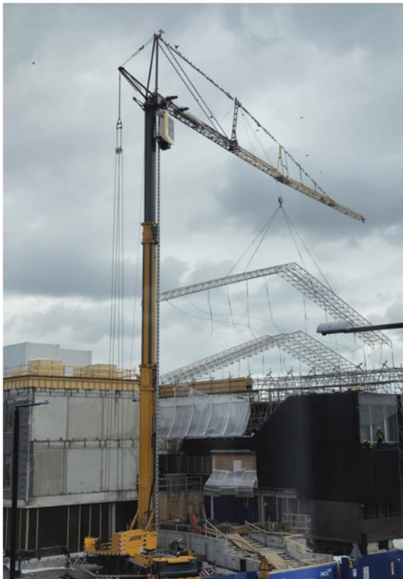
Kuva 1. Sääsuojaristikoiden purkua
