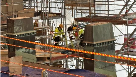
Kuva 3. Teräspalkin siirtoa nostimesta.
