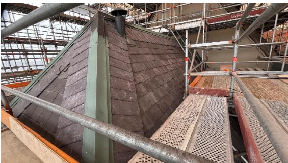
Kuva 7. Pelti ja liuskekiviasennusta Kansantieteellisen osan päädyssä.
