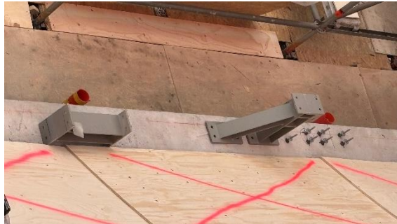
Kuva 6. Pystyrungon asennusta.
