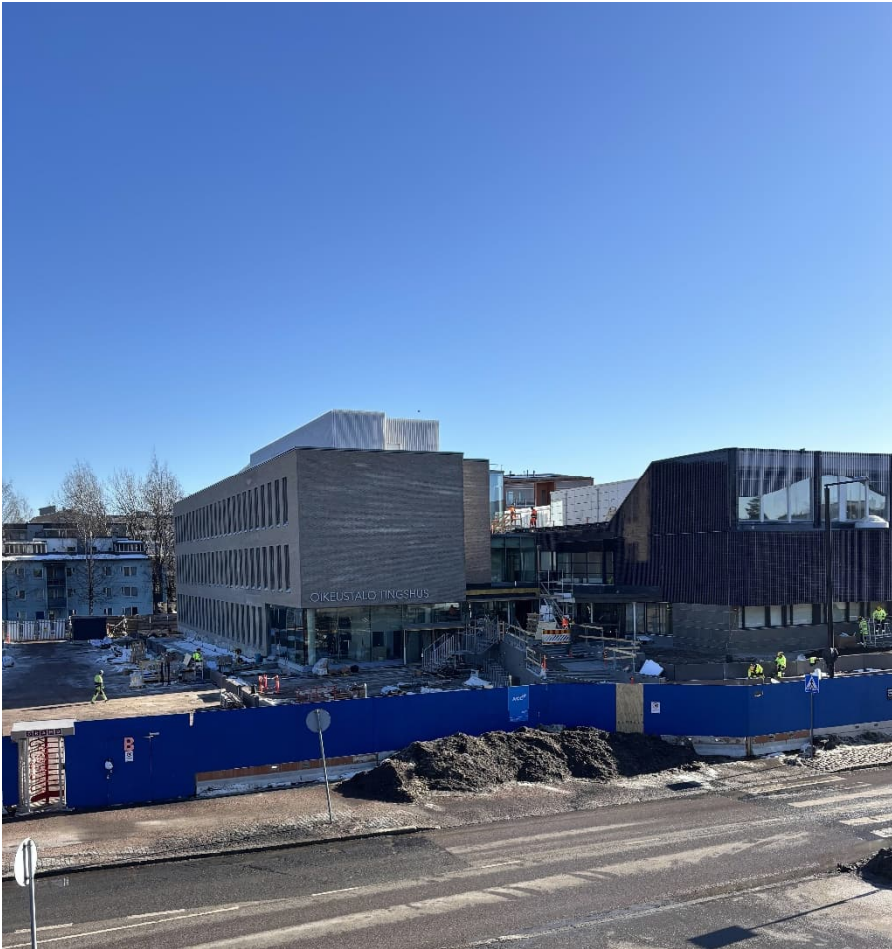
Kuva 1. Lämmin kevätsää sujuvoittaa pihatöiden etenemistä työmaalla.
