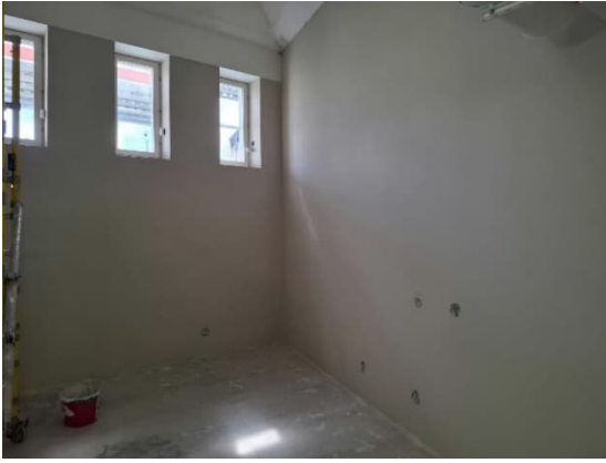
Kuva 1. Vaunuvajan silikaattiseinien valmis maalattu pinta
