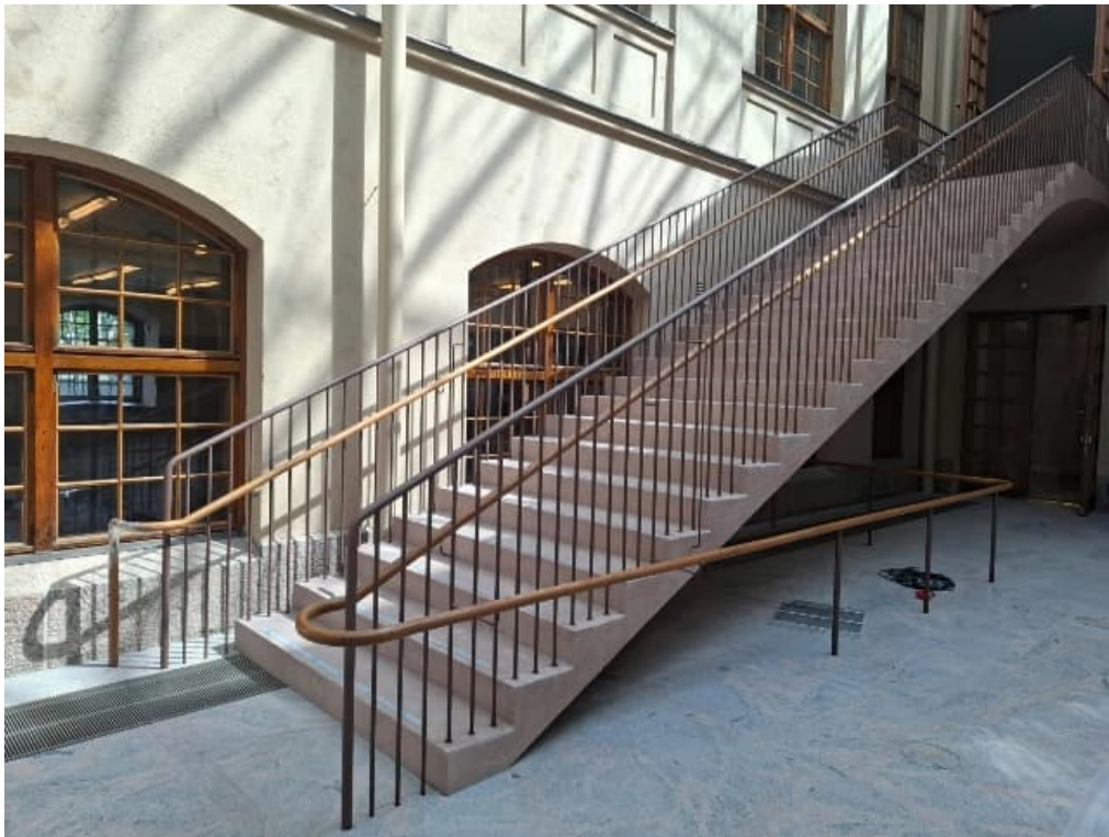
Kuva 3. Halkopihan valmis porraskokonaisuus
