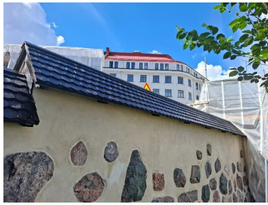
Kuva 2. Tervattu muurin paanukatto
