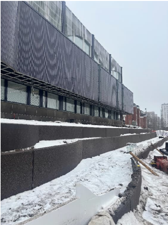
Kuva 1 ja 2. Pihan tukimuurien asennus- ja verhoilutyöt käynnissä.
