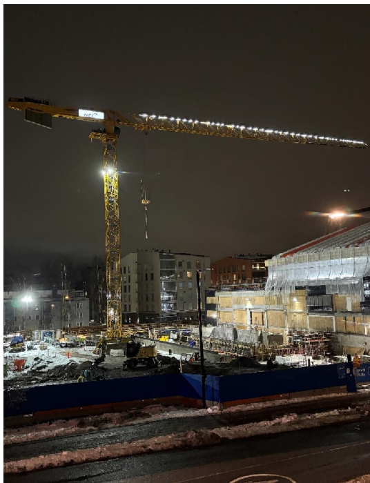
Kuva 1. Työmaan torninosturi on koristeltu jouluvaloilla 🌲
