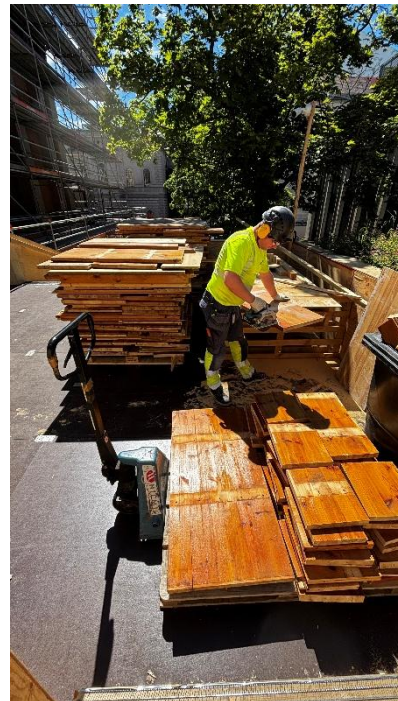
Kuva 15. Hyllyjä, joita ei voi uusiokäyttää, käytetään työmaan aputöissä kiertotalouden hengessä.
