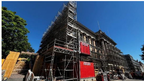
Kuva 2. Telineasennuksia ja rakennushissi A-makasiinissa.
