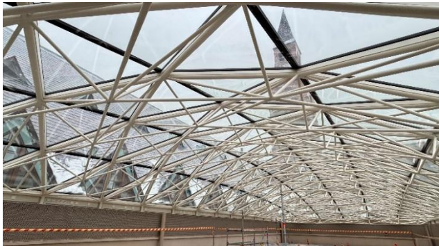
Kuva 1. Halkopihan lasikaton teräsrakenne.
