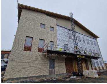
Kuva A-lohkon muuraustöitä
