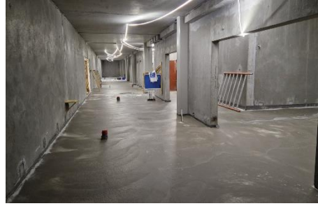
Kuva C-lohkon maanvaraisia lattiaita
