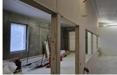
Kuva A-lohkon kevyiden väliseinien työt ovat käynnistyneet
