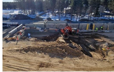
Kuva C-lohkon Maanvaraisen lattian täyttötöyt ja maanpaineseinien asennustyöt käynnissä
