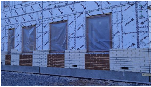
Kuva A-lohkon julkisivun muuraustöitä
