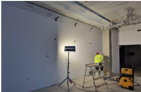
Kuva A-lohkon tasoitus- ja maalaustyöt käynnissä tekstiilityön luokassa
