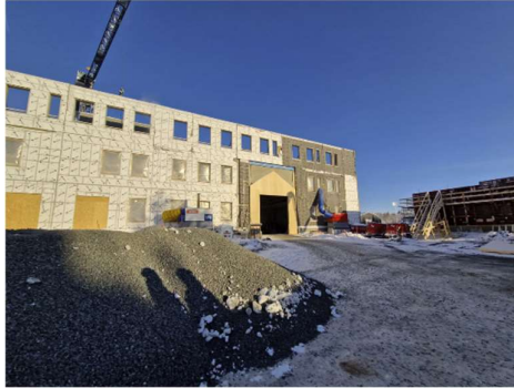
Kuva A- ja C- lohkon kulmaus Nivavaarantielle päin
