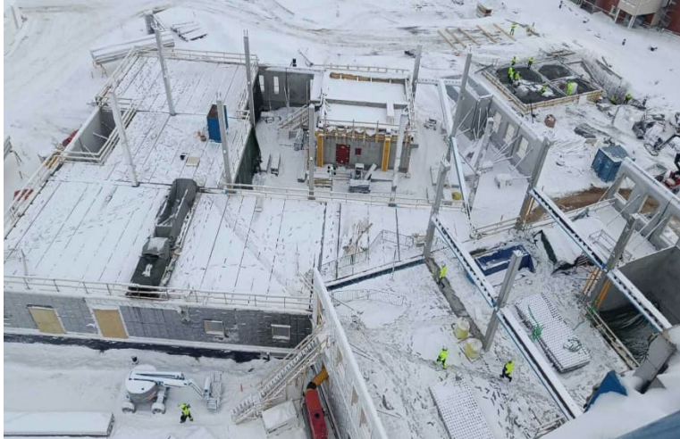
Kuva A -lohkon elementtiasennuksia
