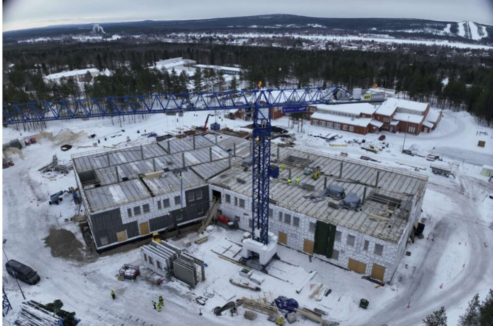
Kuva dronella kuvattu työmaata. Etualalla näkyvät A- ja B-lohkot
