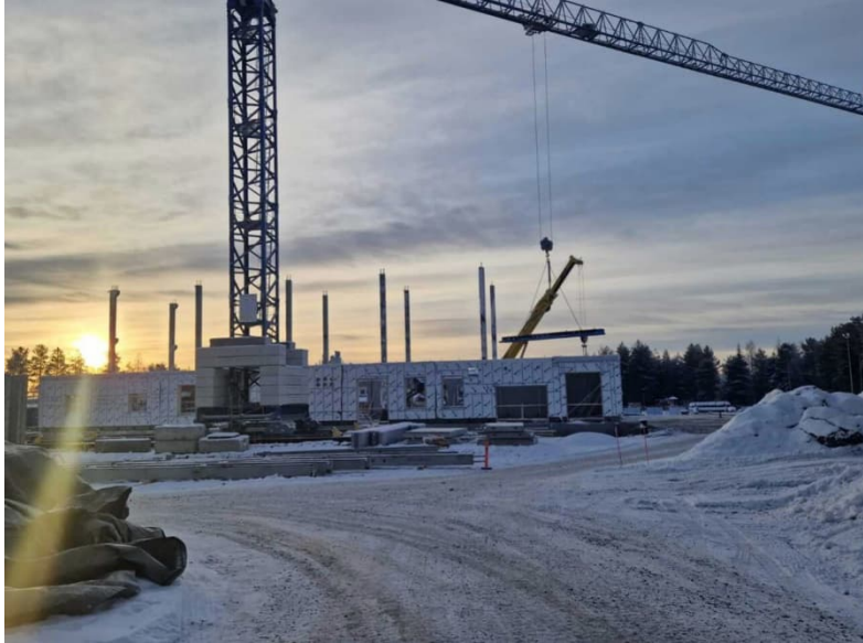
Kuva A -lohkon elementtiasennuksia
