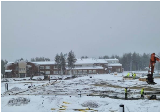
Kuva B-lohkon anturalinjojen tekoa ja lumelta suojaamista
