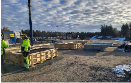
Kuva A-lohkon pilarianturoiden valutyö käynnissä
