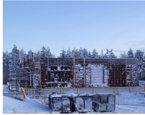
Kuva C-lohkon VSS-muotittöistä
