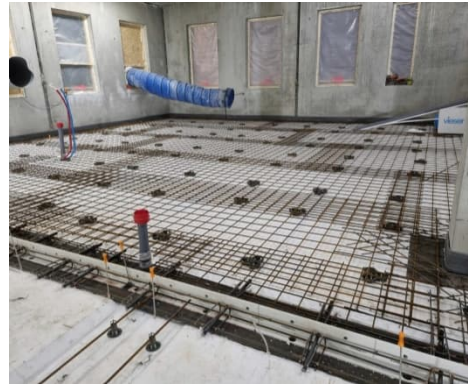
Kuva A-lohkon lattiatyöt
