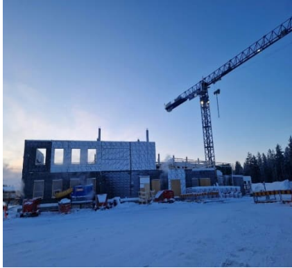
Kuva työmaa Nivavaarantieltä päin
