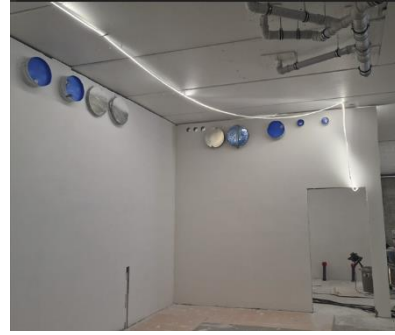
Kuva A-lohkon 1. kerroksen tasoitus- ja maalaustöitä
