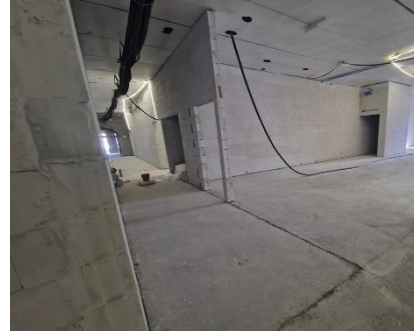
Kuva B-lohkon 1. kerroksen väliseinien muuraustöitä
