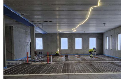
Kuva A-lohkon toisen kerroksen pintalaatan valmistelevat työt ovat käynnissä
