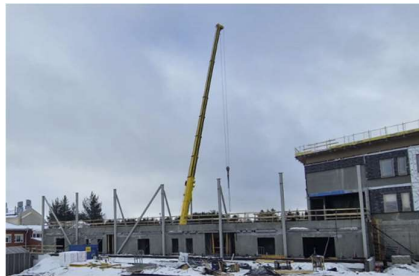
Kuva C-lohkon teräsrunkoasennuksia
