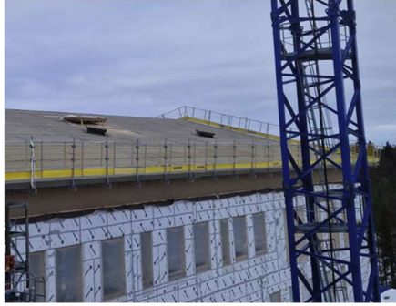
Kuva A-lohkon vesikattoa
