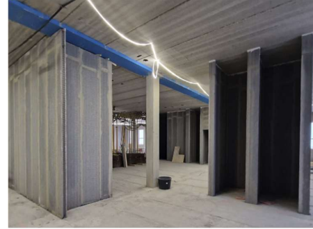
Kuva B-lohkon Ako-asennuksia
