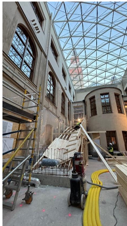
Kuva 4. Betoniportaan pohjamuotti.
