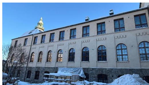
Kuva 10. Telineet purettu Virastosiiven länsipuolelta.
