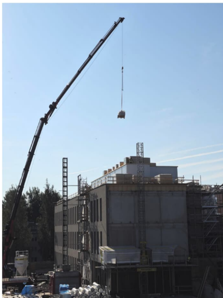
Kuva 1. ja 2. Nostoja uudisosan vesikatolle ja korjausosalle
