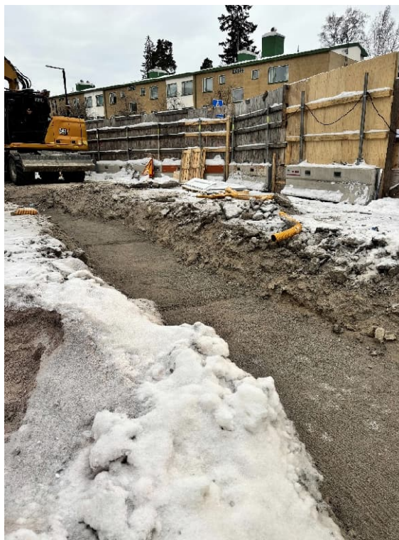
Kuva 1 ja 2. Sisäänkäynnin patsaan perustukset valettu ja pollarien perustustyöt käynnissä.
