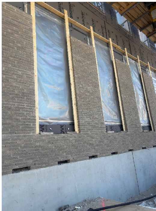
Kuva 1. ja 2. Laajennusosan julkisivumuuraukset käynnissä. Muuraustöissä käytetään apuna mastolavoja.
