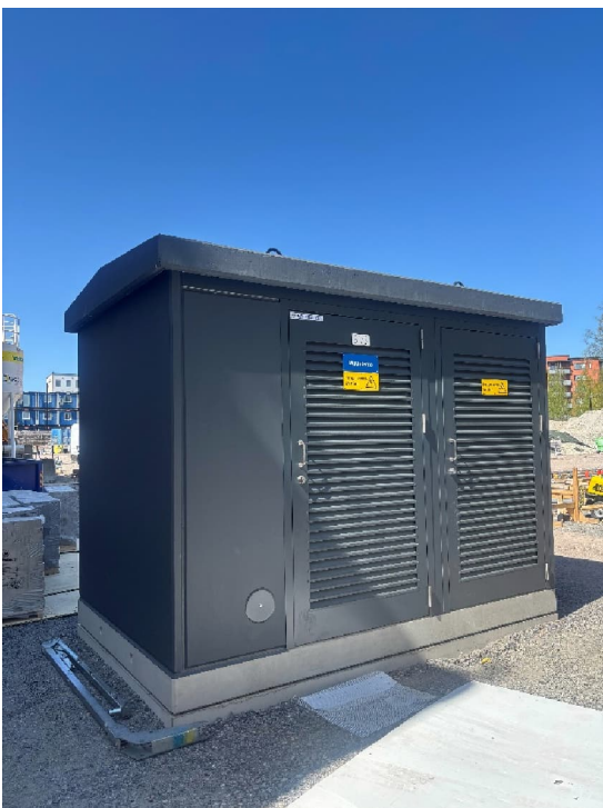
Kuva 3. Puistomuuntamo asennettu tontille.
