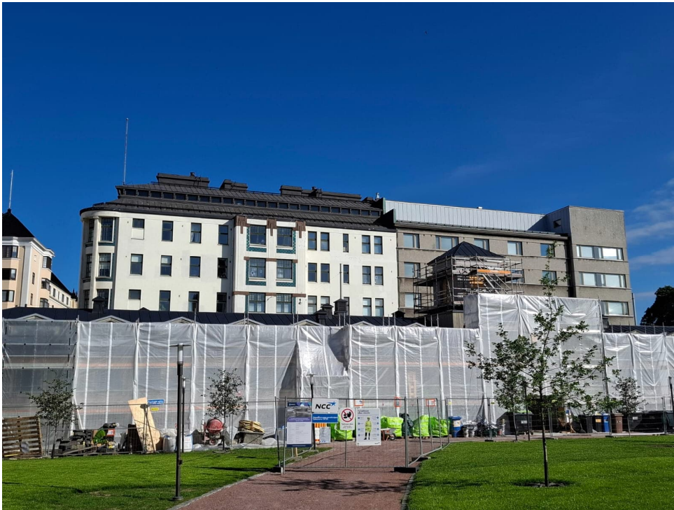
Kuva 3. Vesikaton maalaustyöt ovat hyvällä tahdilla käynnissä
