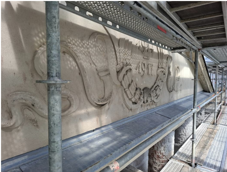
Kuva 3. Toinen kunnostettavista keskirisaliiteistä
