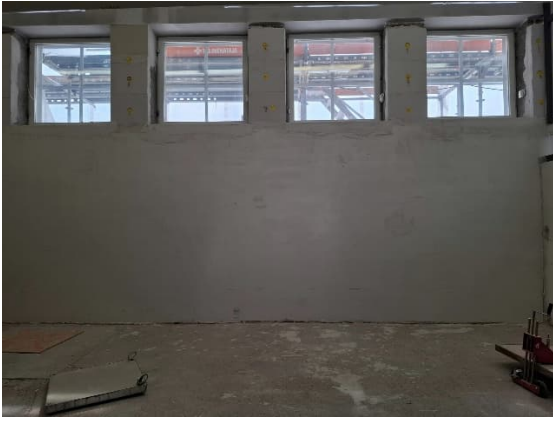
Kuva 1. Valmis rappaus silikaattilevyjen päälle
