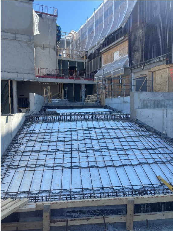
Kuva 1 ja 2. Pääsisäänkäynnin porrasmuotti- ja raudoitustyöt ovat käynnissä.
