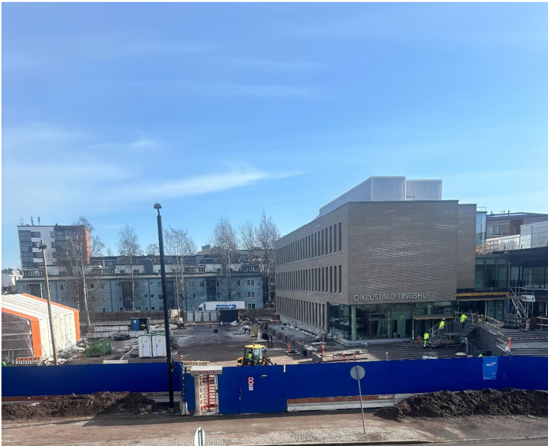
Kuva 1. Korjausosalla käynnissä valaisimien asennukset ja valvojan tarkastukset sekä loppusiivoukset.
