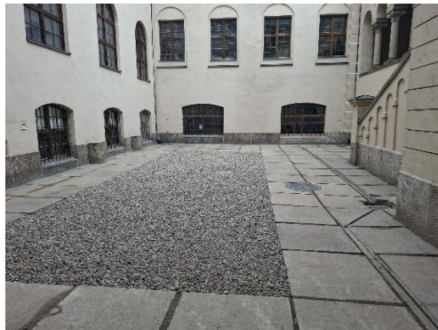
Kuva 3. Vaunuvajan vanhan kylmiöhuoneen lattiavalu Kuva 4. Linnapihalla kaivo on saatu vaihdettua ja kaivanto ummistettua
