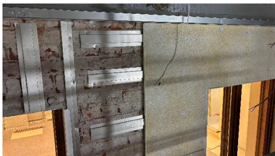
Kuva 2. Taustalevyjen kiinnitystä koolaukseen.
