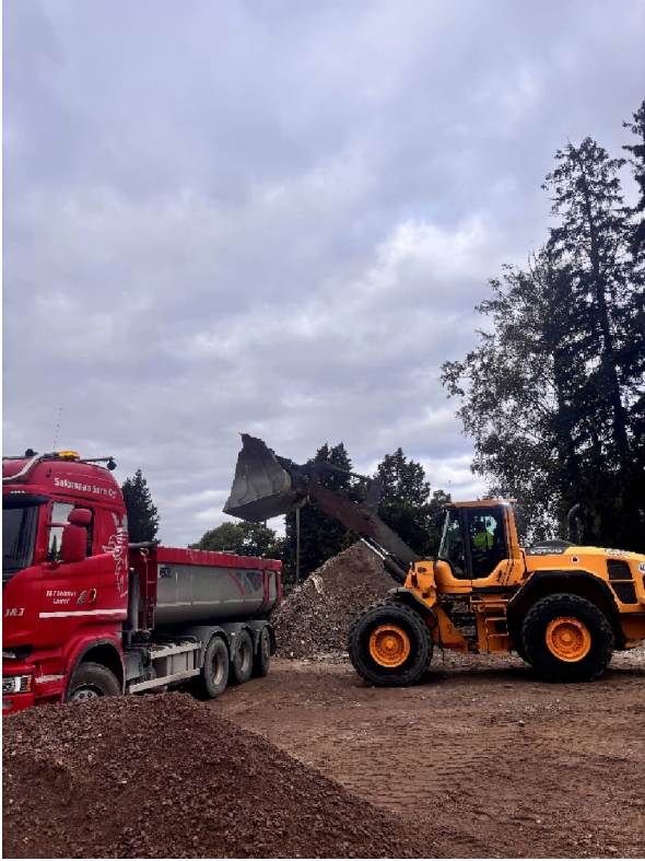
Kuva 1 ja 2. Mara-murskeen siirto käynnissä GRK Suomen VT3 Moreenin eritasoliittymä-hankkeelle Janakkalan ja Hämeenlinnan välisellä tieosuudella.
