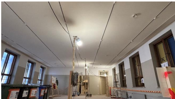
Kuva 3. Virastosiiven toisen kerroksen akustorappausta.
