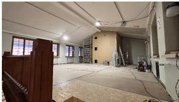
Kuva 4. Hissikuilu yhteistyössä SRV:n kanssa.
