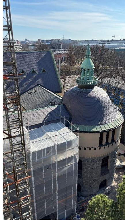
Kuva 8. Vaiheen 1 valmista kattopintaa.
