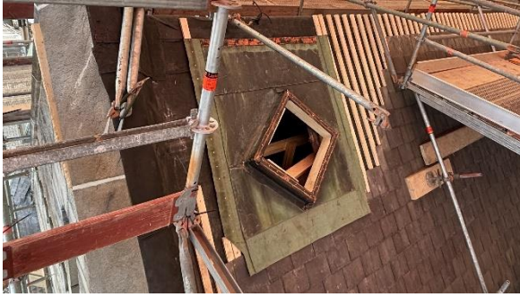
Kuva 6. Pelti- ja liuskekiviasennuksia.
