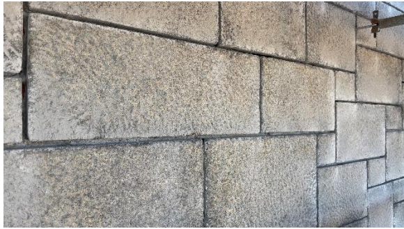
Kuva 7. Julkisivun kivisaumausten avaus valmistunut.
