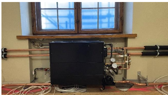
Kuva 5. Puhallinkonvektorien asennusta.
