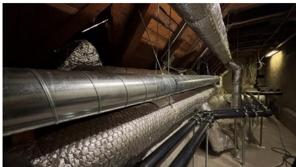
Kuva 6. Uusia ilmastointireittejä ullakolla.
