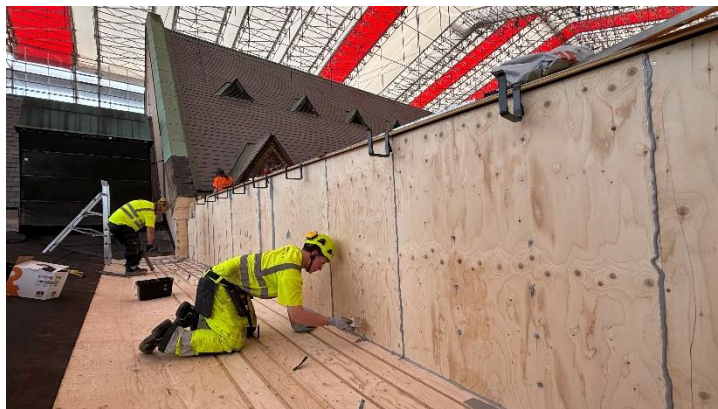
Kuva 5. Halkopihan sokkelin saumojen kittausta.
