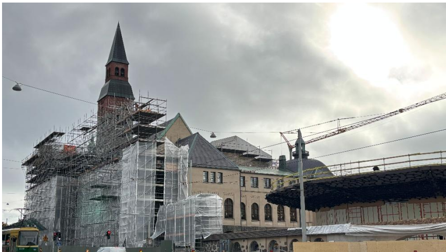
Kuva 6. Telinepurku aloitettu Mannerheimintielle.
