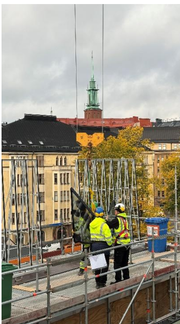
Kuva 1. Lasin valmistelua nostoon.
