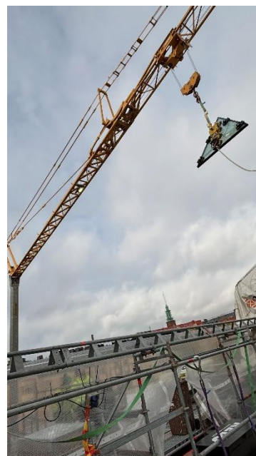
Kuva 2. Lasin nosto Virastosiiven katon yli.
