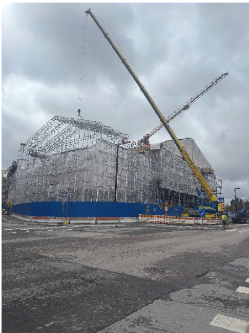
Kuva 1 ja 2. Sääsuojan purkutyöt osa kerrallaan on aloitettu viikolla 17.
