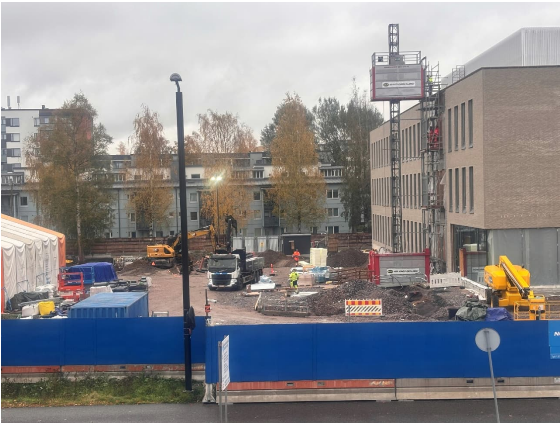
Kuva 1. Maarakennustyöt etenevät laajennusosalla.
