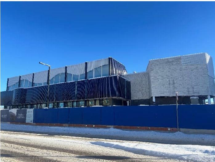
Kuva 1 ja 2. Korjausosan julkisivun kunnostukset hyvällä mallilla.
