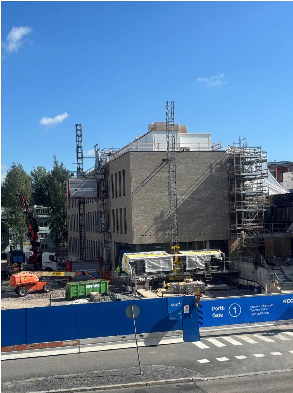
Kuva 1. Julkisivun muuraustyöt lähes valmistuneet lukuun ottamatta työmaahissin kohtaa ja harus paikkauksia.
