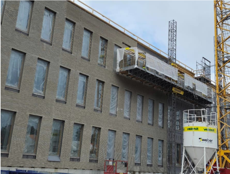
Kuva 1. Julkisivun muuraustyöt käynnissä laajennusosalla
