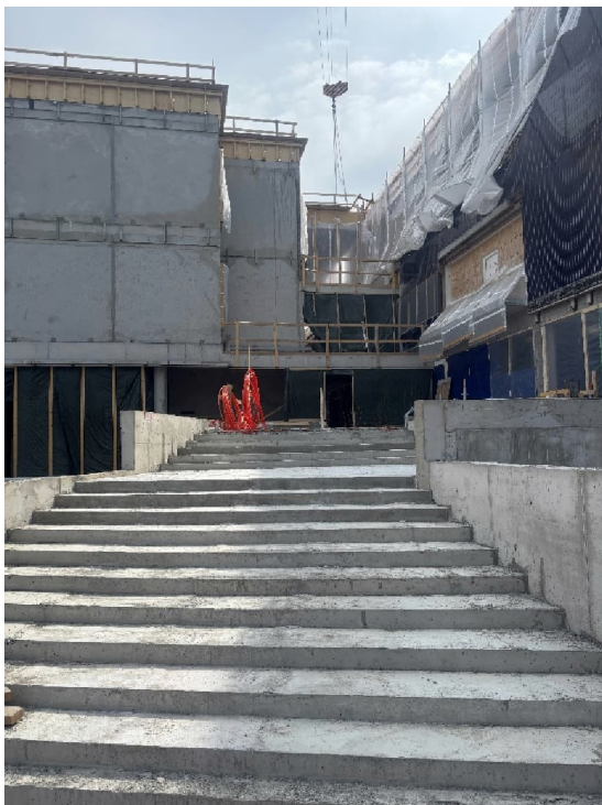
Kuva 1. Pääsisäänkäynnin portaat valettu.
