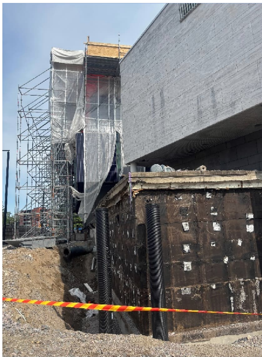
Kuva 2. Salaojen tarkastuskaivojen työt käynnissä.
