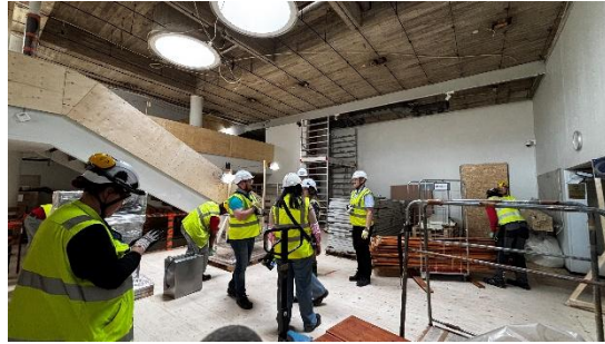
Kuva 8. Vieraita tutustumassa työmaahan.
