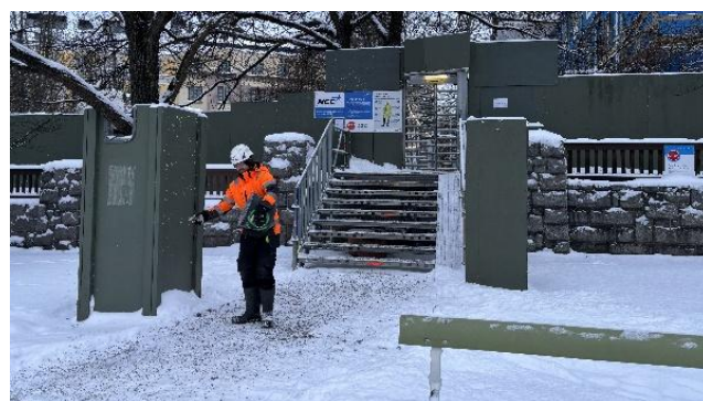
Kuva 2. Hiekoitusta työmaan edustalla.
