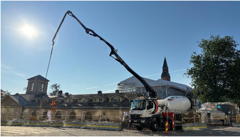
Kuva 5. Vaunuvajan sokkelin valua.
