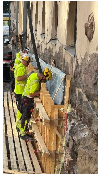
Kuva 6. Vaunuvajan sokkelin valua.
