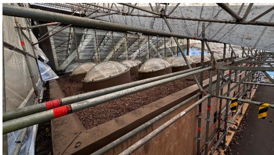
Kuva 1. Sääsuoja Uuden tutkijasalin yllä.
