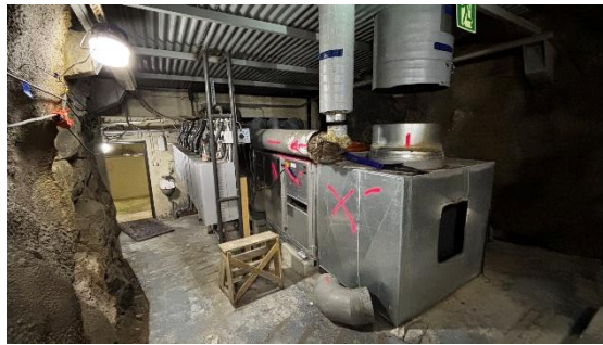
Kuva 4. Poistettavia ilmanvaihtokoneita.
