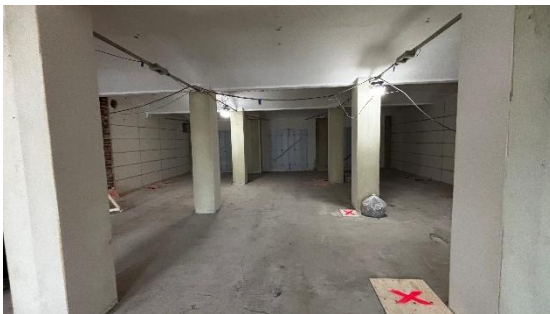
Kuva 5–6. Tiloja, joissa purkutyöt valmiit.
