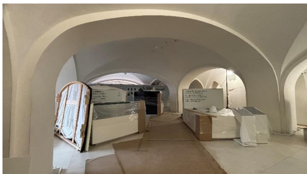
Kuva 4. Näyttelyrakenteiden pystytys alkanut.
