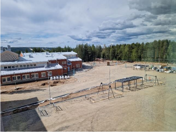
Kuva Eteläpihan asfalttiprofilointia
