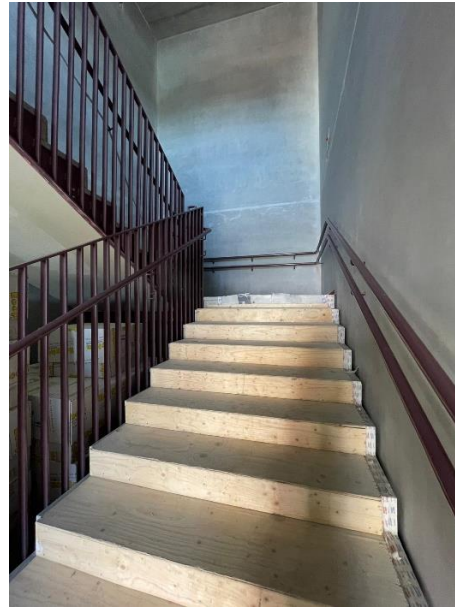
Kuva C-lohkon käsijohdeasennukset.
