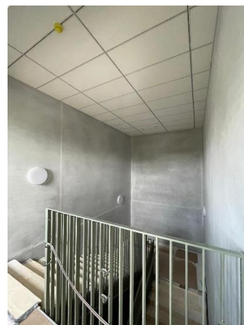
Kuva A-lohkon porraskäytävä
